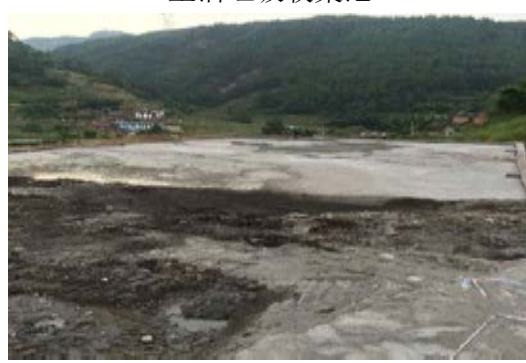
废水池固化（池顶硬化）
