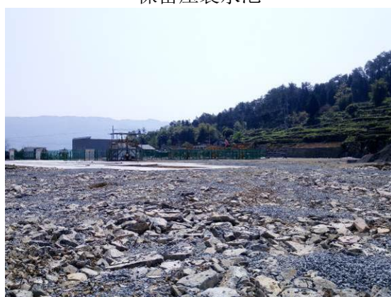
井口硬化、井场碎石铺垫防渗
