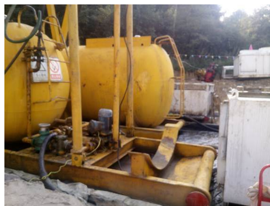
柴油罐底部围堰+防渗膜
