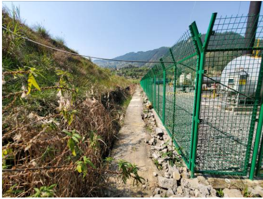
井场周边截排水沟
