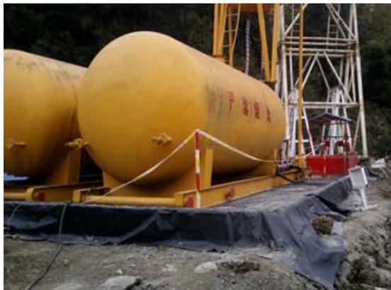
图 6-1 油罐区围堰、防渗
