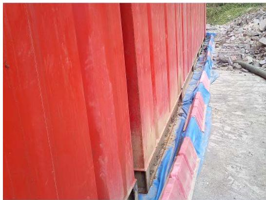
图 6-2 液罐区围堰、防渗
