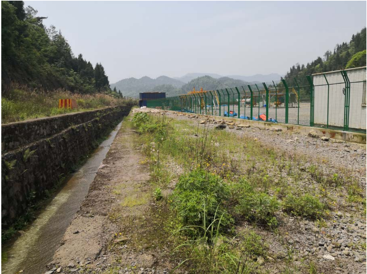
21#西平台临时占地生态恢复
