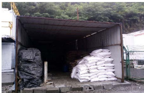
焦页 27#平台药品堆放区基础及围堰
