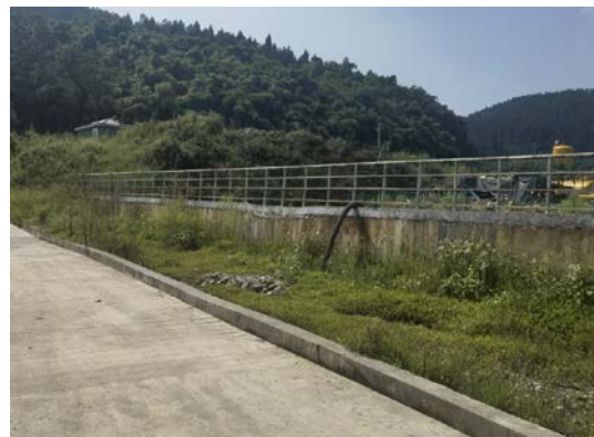
29#平台截排水沟及水池周边临时占地绿化
