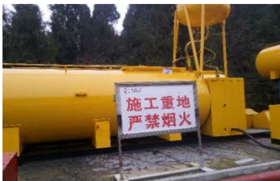
焦页 27#平台柴油罐区防渗及围堰
