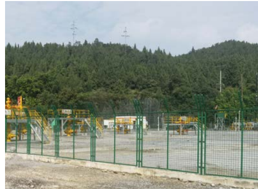
27#平台井场碎石铺垫
