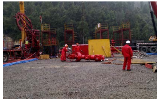
30#东井场碎石铺垫(试气压裂工程)
