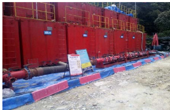
焦页 27#平台压裂设备基础防渗
