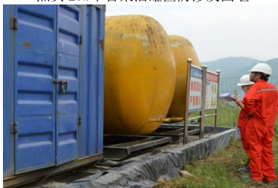
焦页 29#平台柴油罐区防渗及围堰
