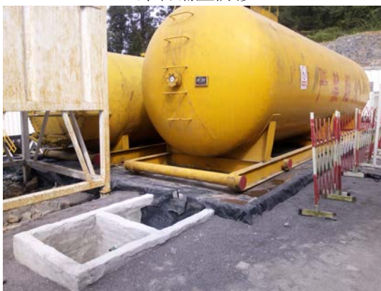
罐区围堰及防渗
