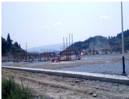
碎石铺垫防渗
