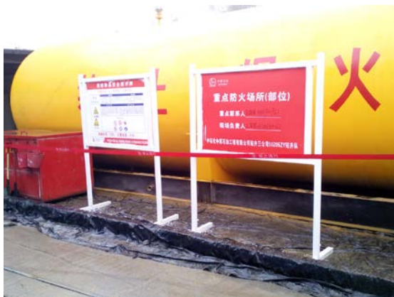
焦页 11#北柴油罐防渗+围堰
