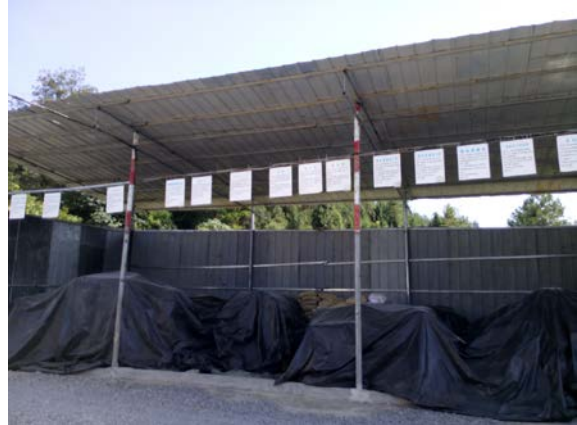
焦页 11#西材料暂存区防渗+雨棚
