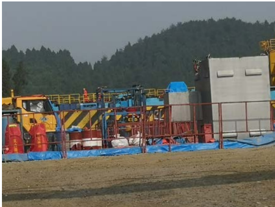
焦页 11#北压裂设备围堰
