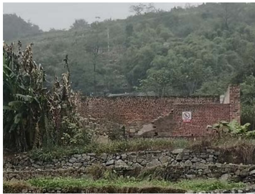
11#北平台放喷池
