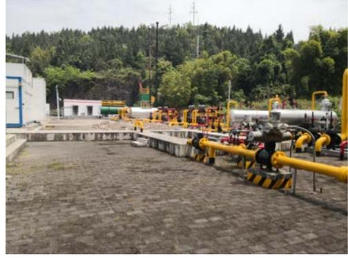
27#扩平台水套炉及采气流程
