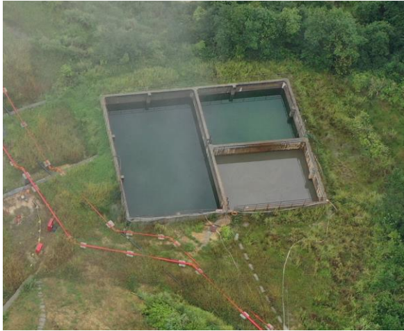
废水池暂存池
