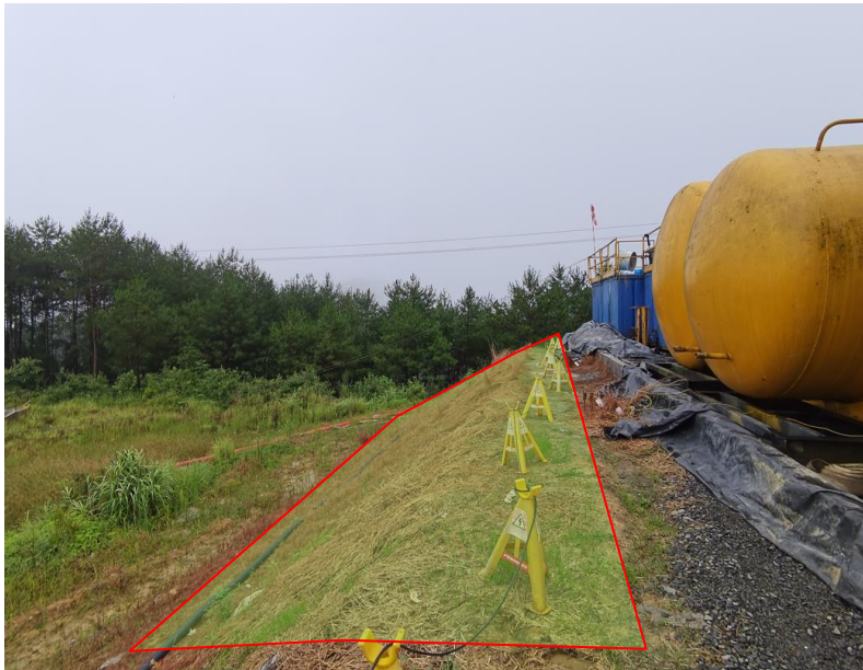
井场边坡处理
