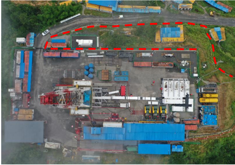
井场边排水沟
