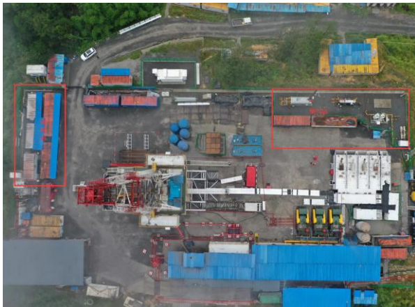
井场混凝土地面防渗
