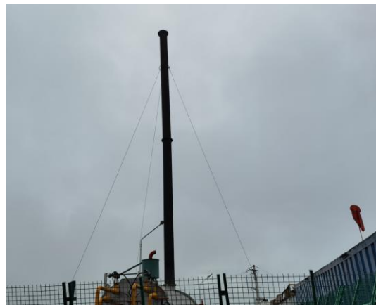
水套加热炉排气筒
