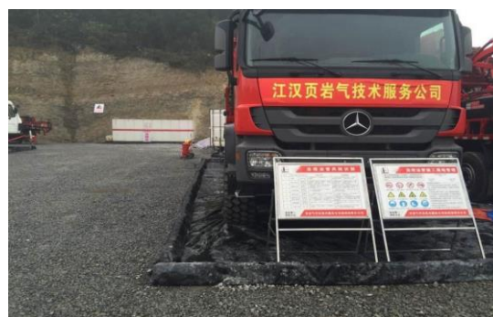
防渗膜、围堰措施照片
