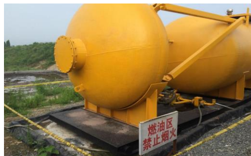
油罐环保防护措施照片
