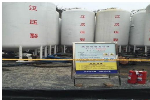
酸罐区防渗膜、围堰措施照片
