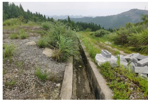
钻井平台废水沟
