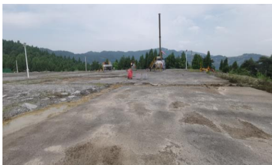
钻井平台硬化现状
