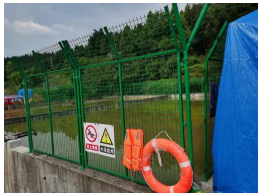
钻井平台废水池
