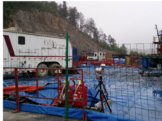
压裂设备防渗+围堰
