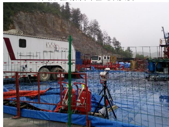
压裂设备防渗+围堰
