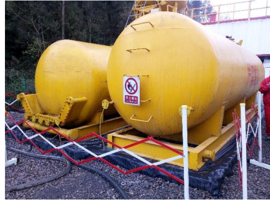
柴油罐底部围堰+防渗膜
