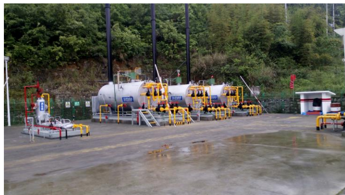
水套炉排气筒
