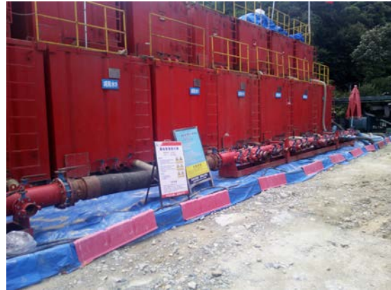
压裂设备防渗+围堰
