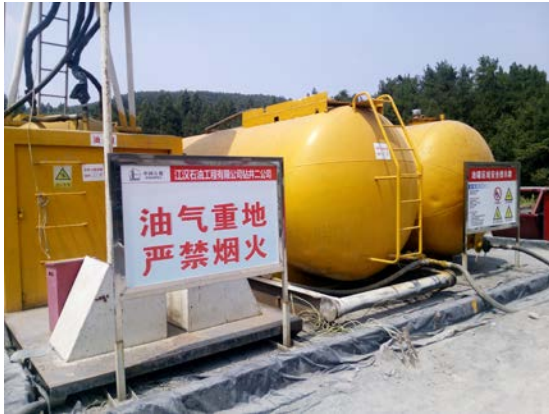
柴油罐底部围堰+防渗膜
