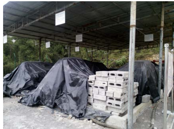
焦页 39#东材料暂存区防渗+雨棚
