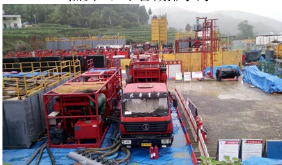
焦页 40#平台压裂设备围堰+防渗
