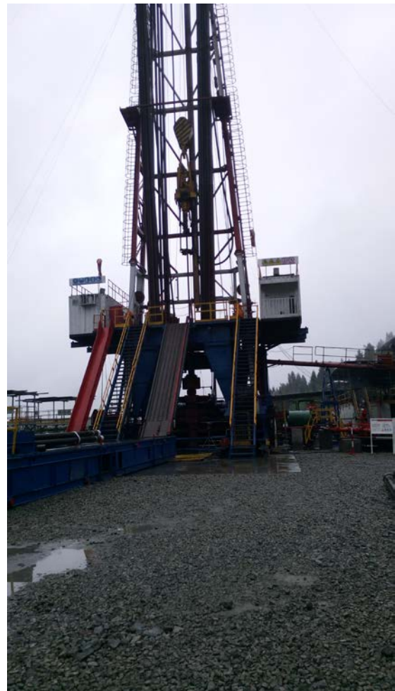
焦页 30#东碎石铺垫井场
