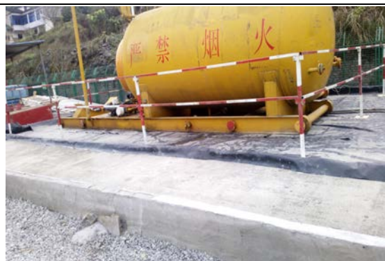
焦页 40#平台柴油罐围堰
