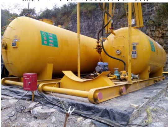
焦页 40#平台柴油罐围堰+防渗
