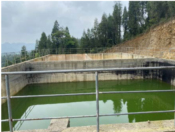
焦页 39#东废水池
