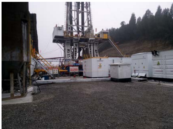
焦页 39#东碎石铺垫井场
