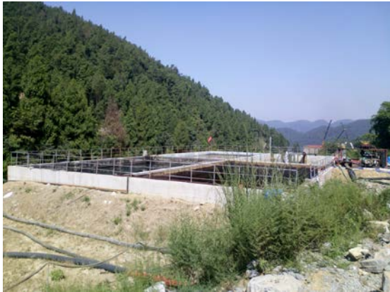
焦页 30#东废水池
