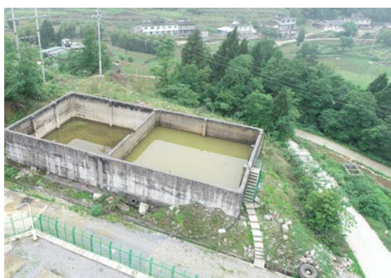
焦页 41#平台废水池
