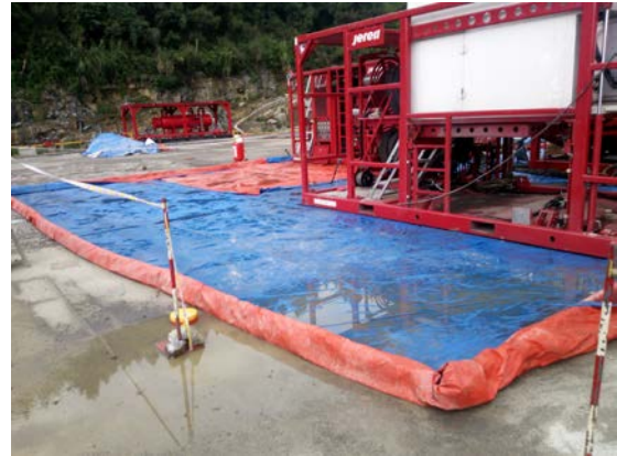
30#东压裂设围堰+防渗膜
