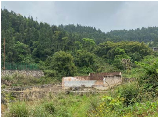
39#集气站放喷池
