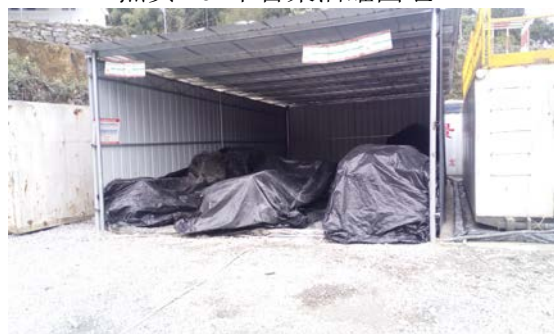
焦页 40#平台材料暂存区防渗+雨棚
