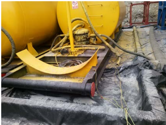
焦页 39#东柴油罐防渗+围堰
