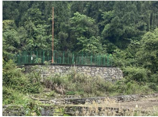
39#集气站放空立管
