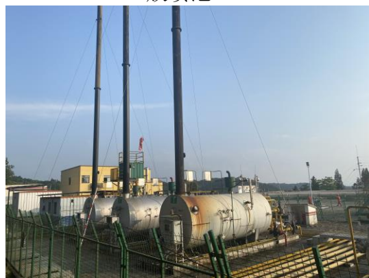
水套炉及排气筒
