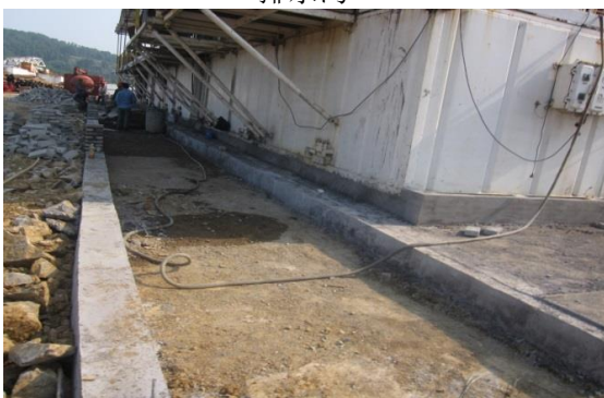
泥浆罐基础及围堰
