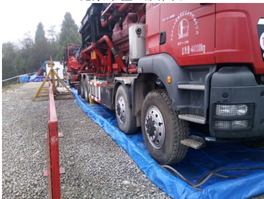
压裂设备基础防渗
