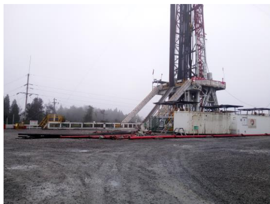
井场碎石铺垫防渗
