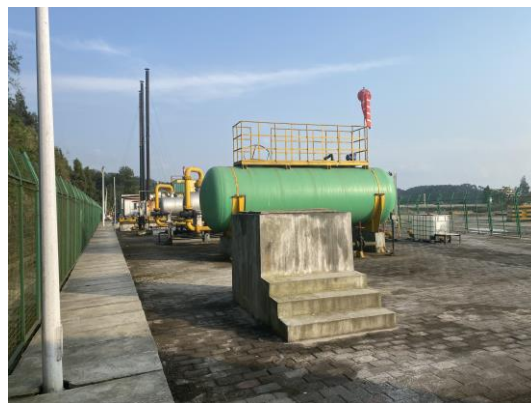
集气站污水罐
