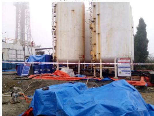
盐酸罐基础围堰
