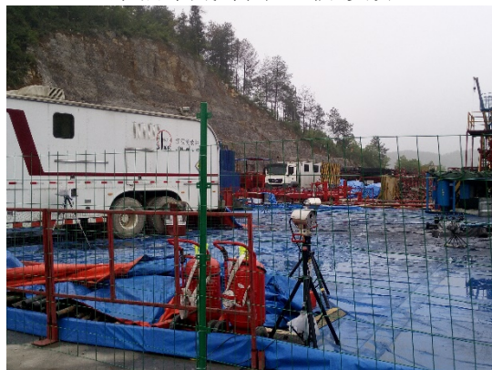
压裂设备防渗+围堰
