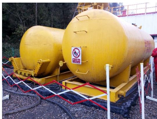
柴油罐底部围堰+防渗膜
