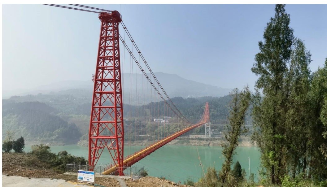
图 4.2-2 乌江悬索跨越现场照片
