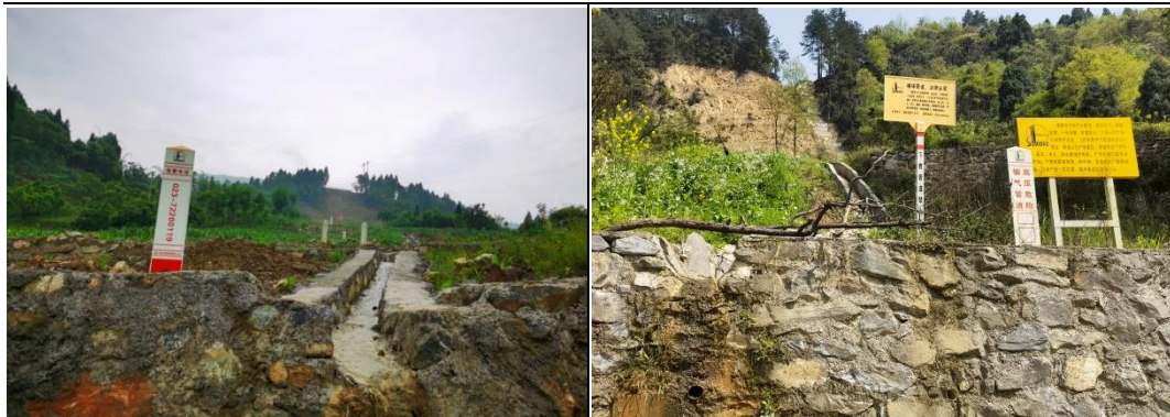
边坡截排水沟及配套急流槽
