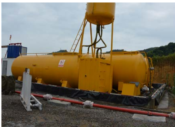
焦页 69#平台柴油罐基础及围堰
