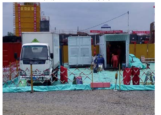
焦页 85#平台压裂作业区底部铺防渗及围堰
