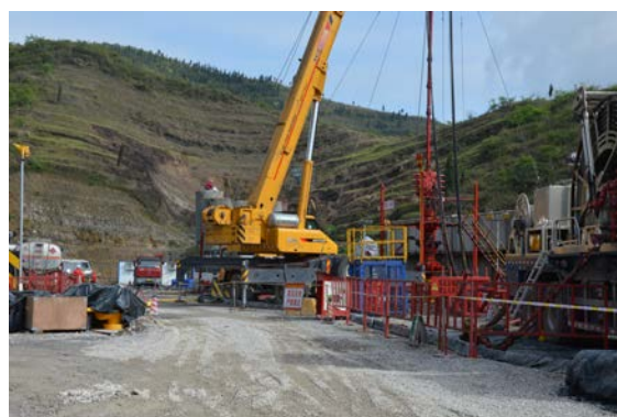
焦页 81#平台压裂区铺设防渗及围堰
