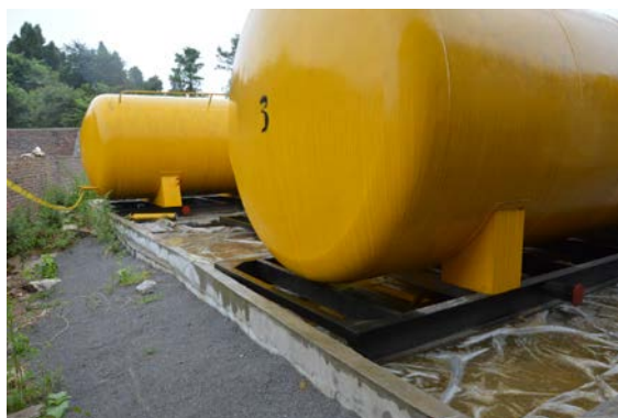
焦页 6#平台柴油罐基础及围堰
