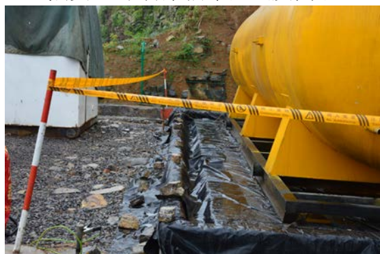
焦页 66#平台柴油罐基础及围堰
