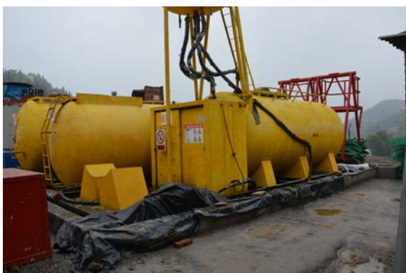
焦页 70#平台柴油罐基础及围堰
