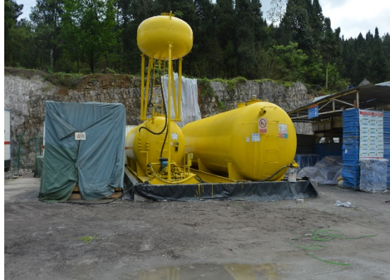
焦页 85#平台柴油罐基础及围堰
