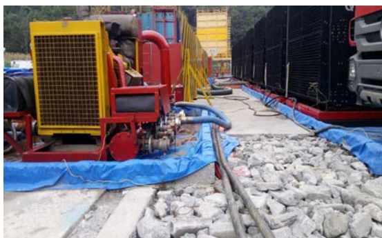
焦页 66#平台压裂作业区铺防渗及围堰
