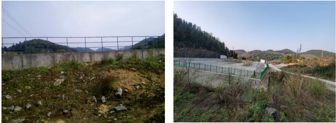
边坡植被恢复、植草绿化
