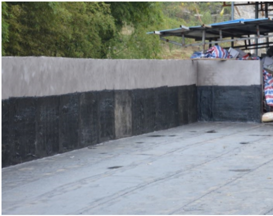
钻屑储存区基础及围堰
