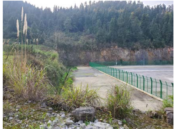
井场截排水沟
