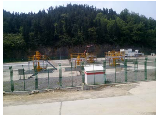
井场铺垫+防渗
