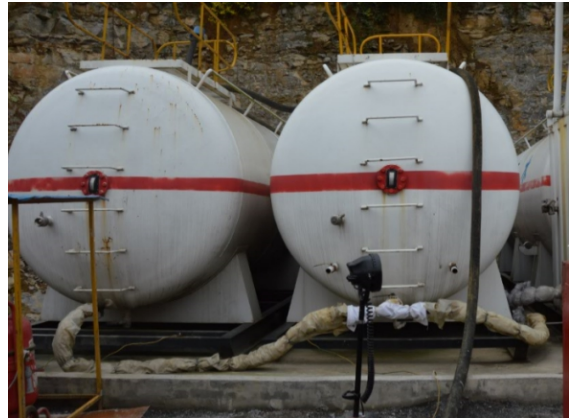
柴油罐基础及围堰
