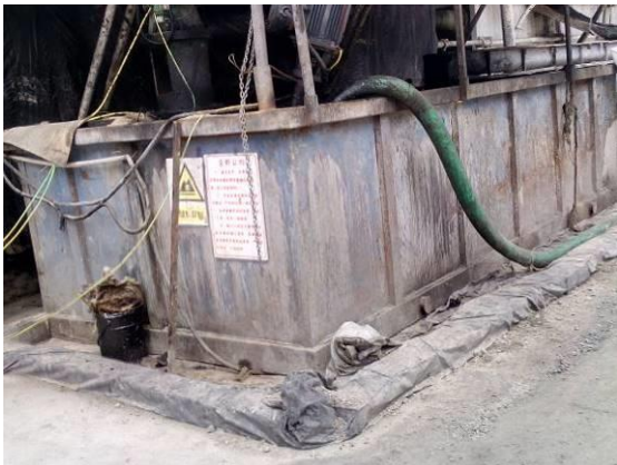
油基岩屑循环罐(钢质罐+底部防渗膜)
