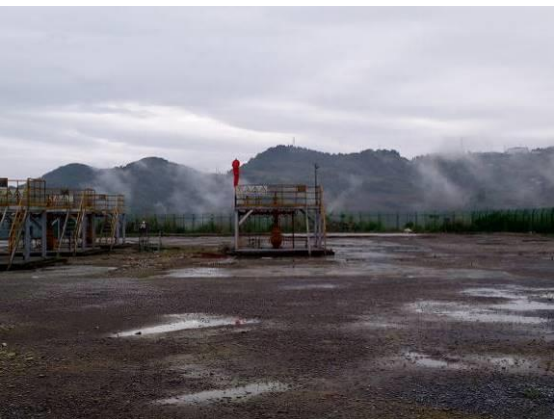
井场硬化及碎石铺垫
