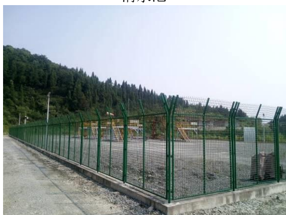
井口硬化、井场碎石铺垫防渗
