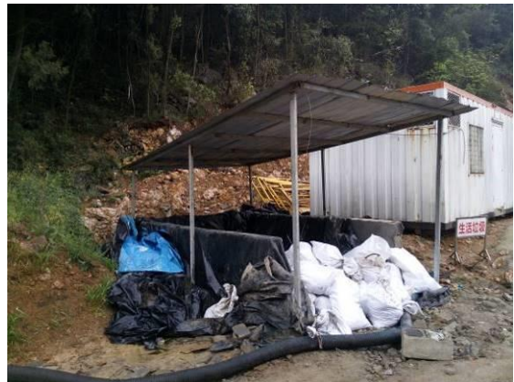
生活垃圾收集池
