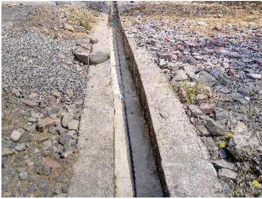
井场周边截排水沟
