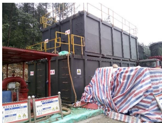
盐酸罐底部围堰+防渗膜
