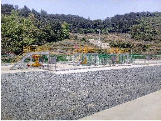
井场硬化及碎石铺垫
