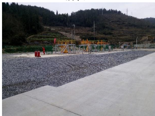
井口硬化、井场碎石铺垫防渗
