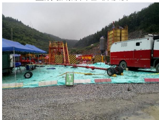
压裂设备防渗+围堰
