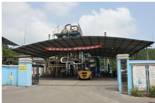
1号油基钻屑处理站及装卸区雨棚
