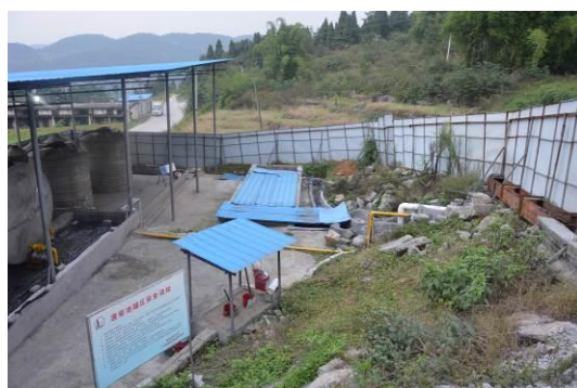
污水处理设施及废油罐区
