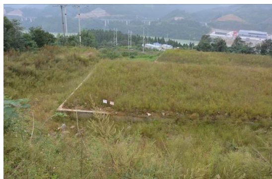
临时占地进行生态恢复部分（61#平台）
