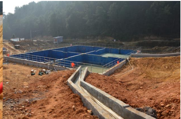
通往废水池的排污沟
