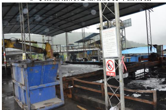
油基钻屑暂存池
