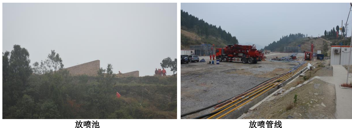
图 7.1-1 钻井期间大气污染防治措施
