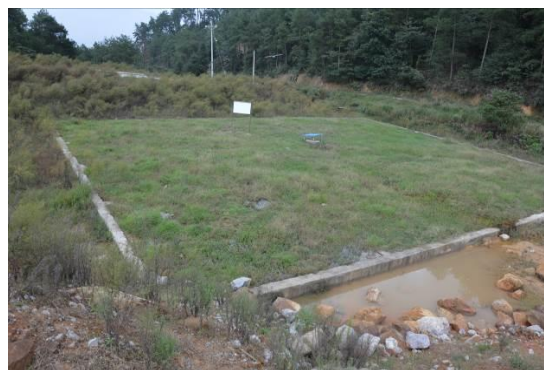
废水池覆土及撒草绿化（63#平台）
