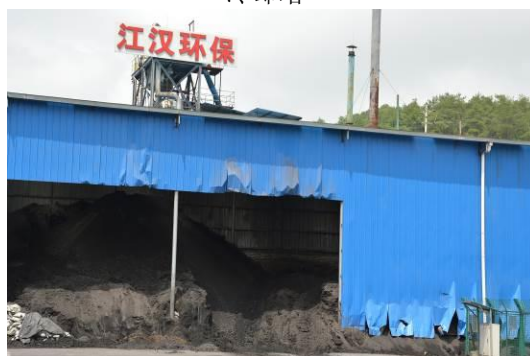
1#油基钻屑灰渣暂存场
