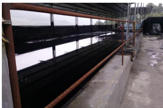
油基钻屑暂存池
