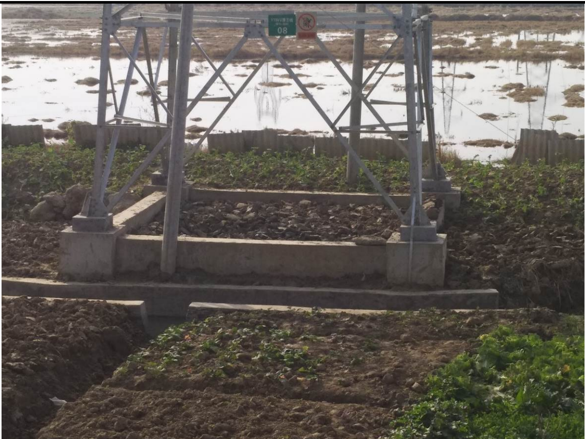
110kV潜王线#8号塔 植被恢复情况
