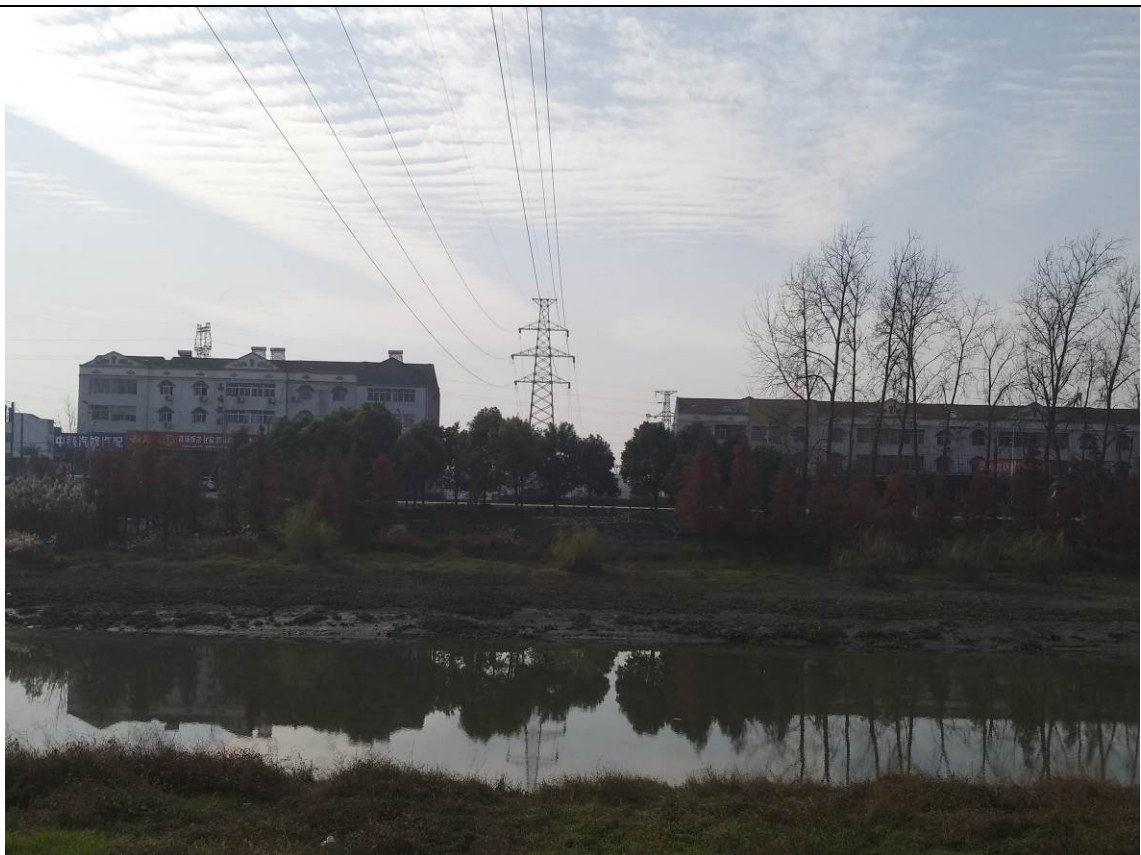
110kV潜王线改造段一杆跨越东干渠
