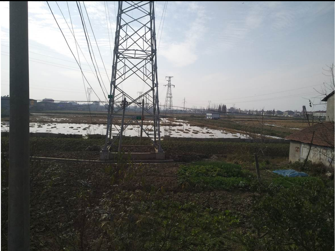
110kV潜王线#8号塔及线路情况
