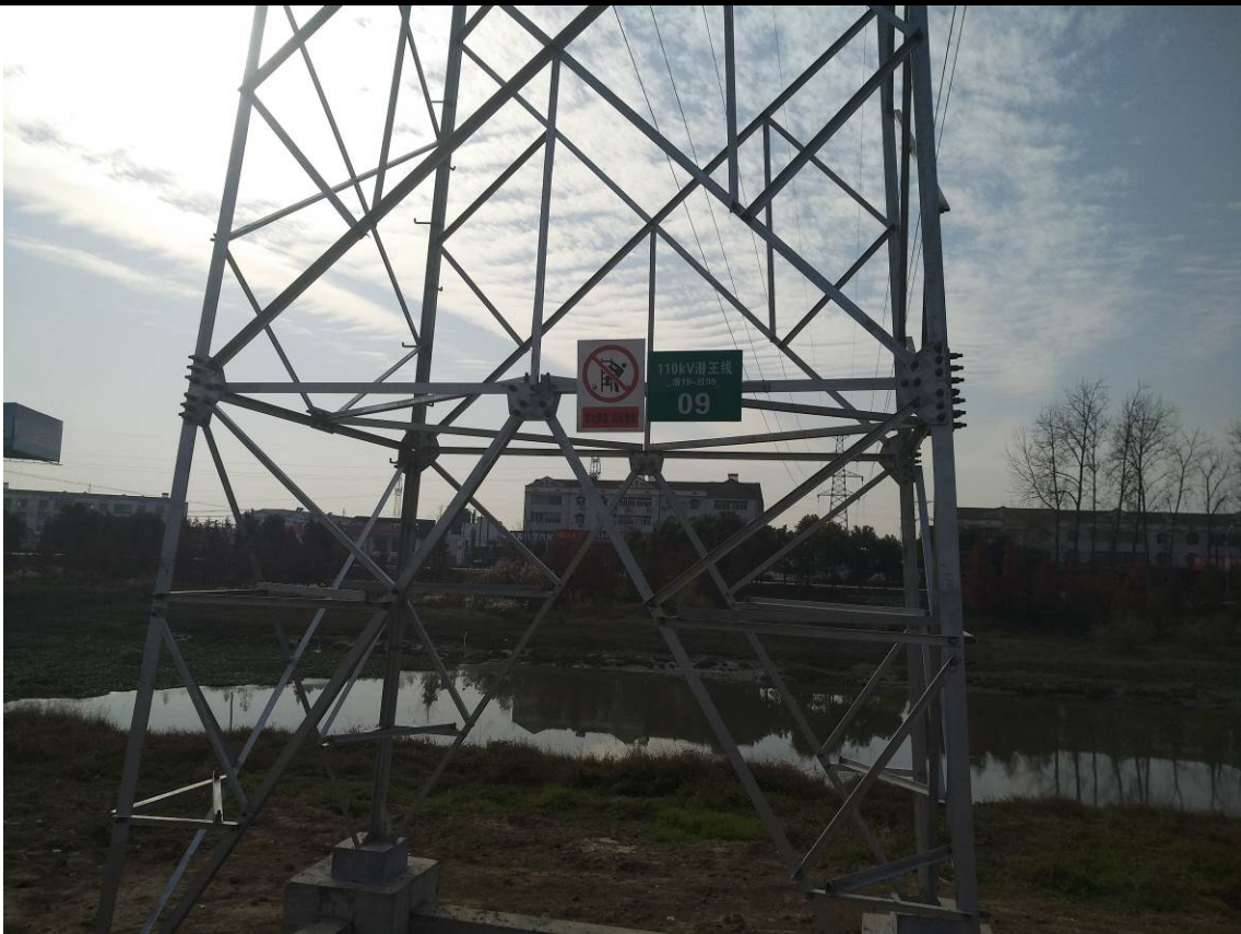
110kV潜王线#9号塔及线路情况
