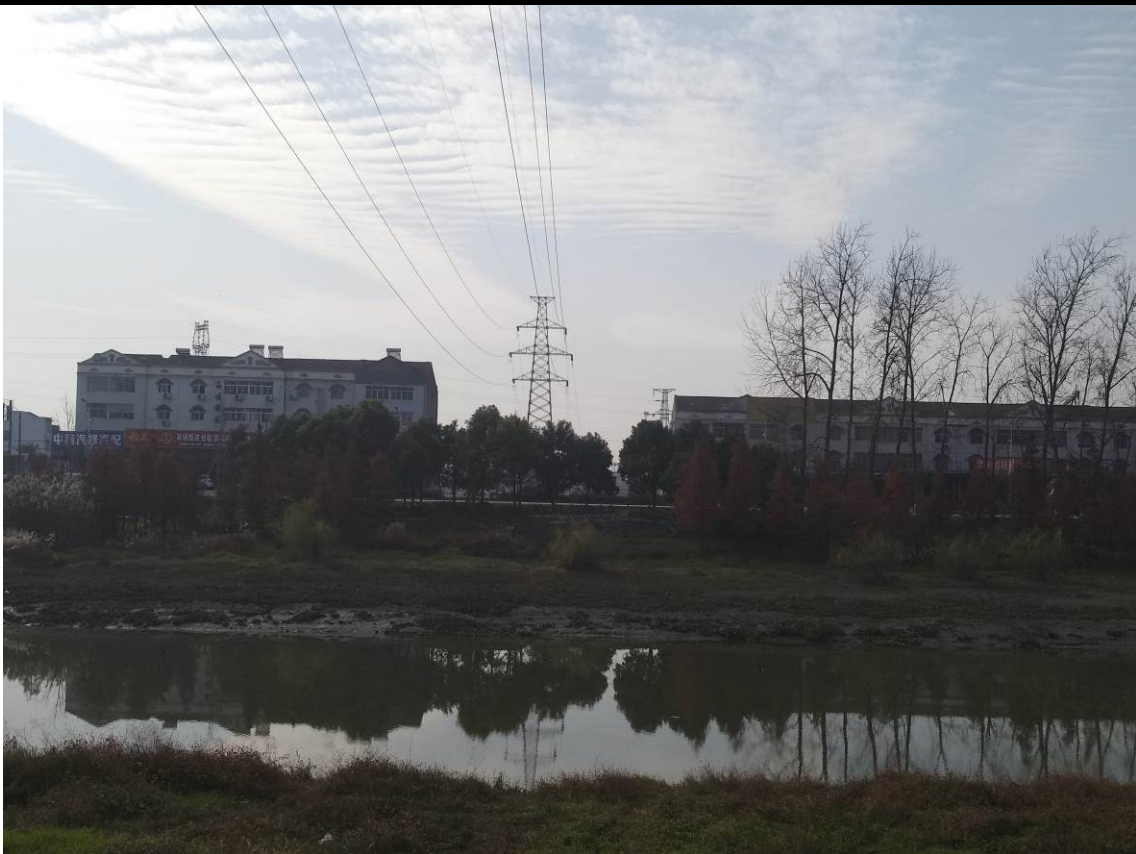
110kV潜王线改造段跨越东干渠
