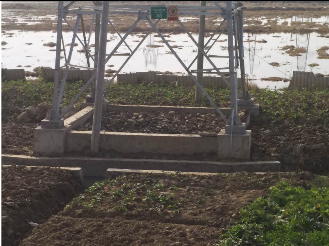
110kV 潜王线杆塔土地复垦情况
