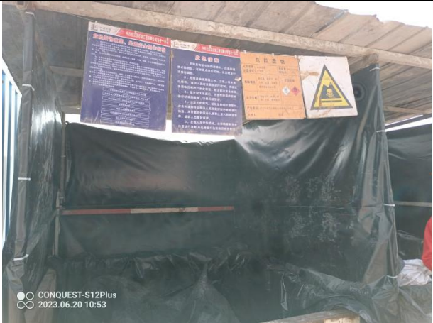
危险废物暂存区（标识标牌）
