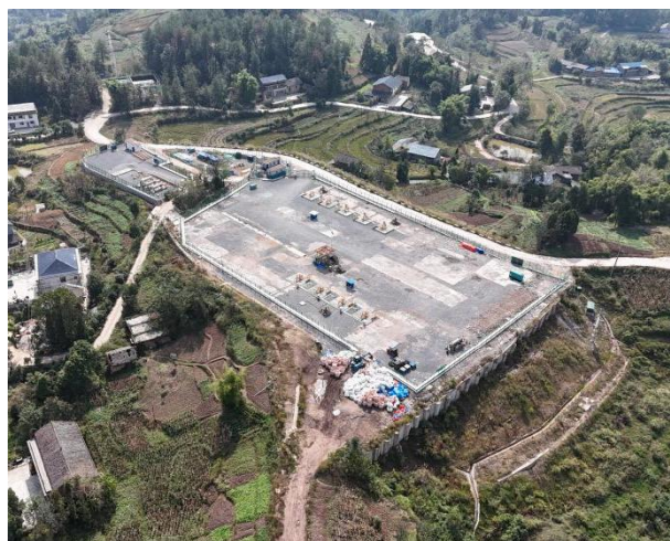
井场碎石铺垫
