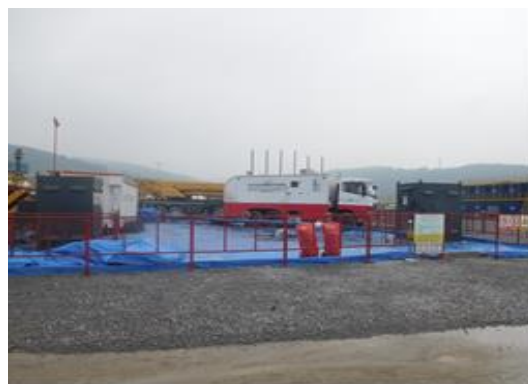
施工期采取的防渗措施
