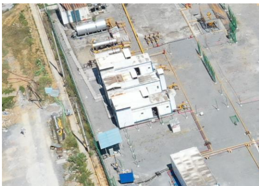
压缩机（置于撬装内）
