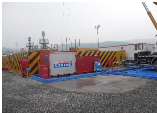
施工期采取的防渗措施
