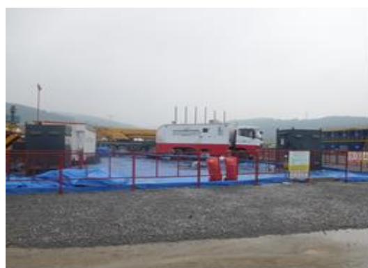
施工期采取的防渗措施
