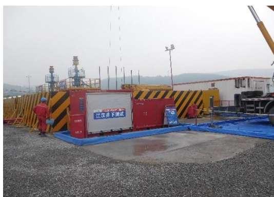
施工期采取的防渗措施
