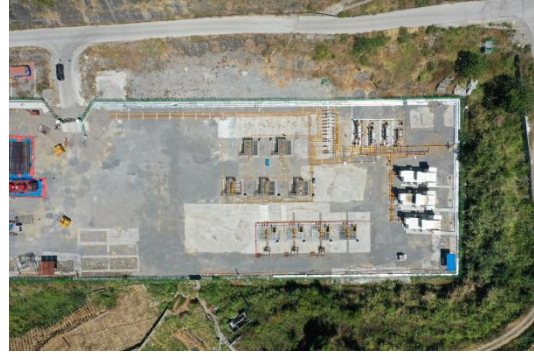
井场硬化（焦页 19 号平台）
