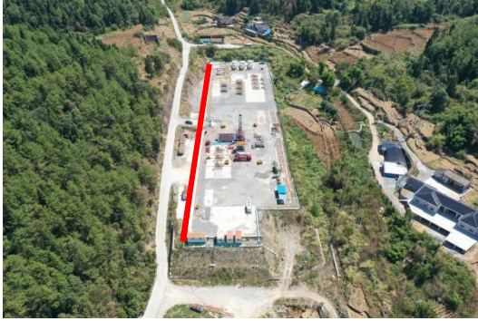
截排水沟（焦页 19 号平台）
