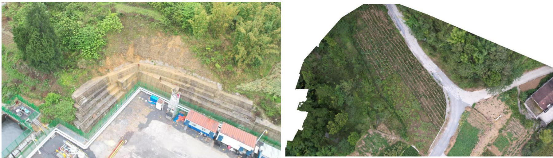
边坡挡墙及截排水沟
