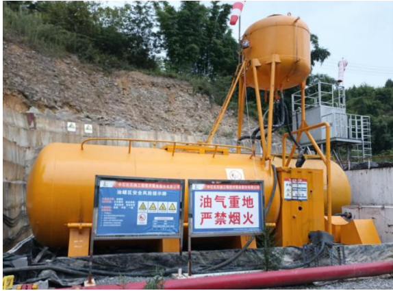
柴油罐区及围堰
