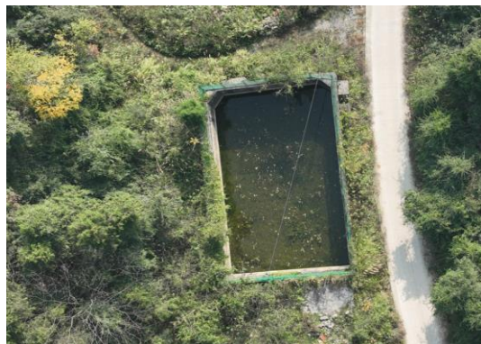
植被恢复（放喷池）
