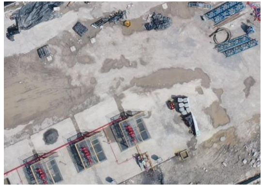
井场硬化（焦页 81 号西）
