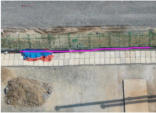
截排水沟（焦页 6 号西）
