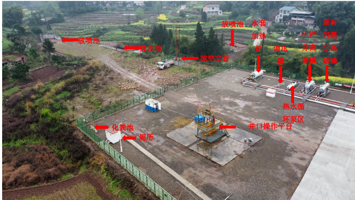
东北侧放空池、废水池所在区域现状图
