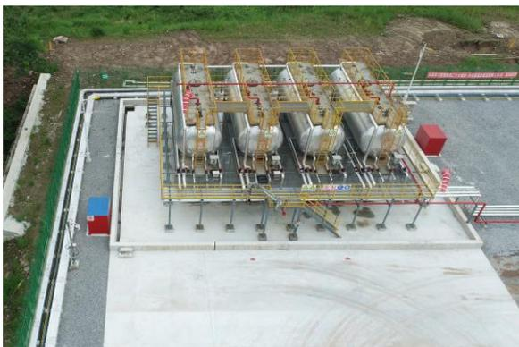
高架油罐区地面硬化设置围堰
