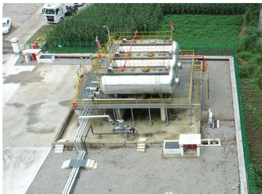
高架油罐区地面硬化、设置围堰
