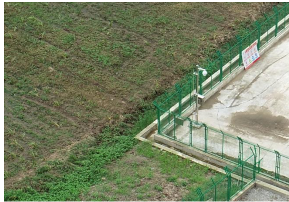
井场周边截排水沟
