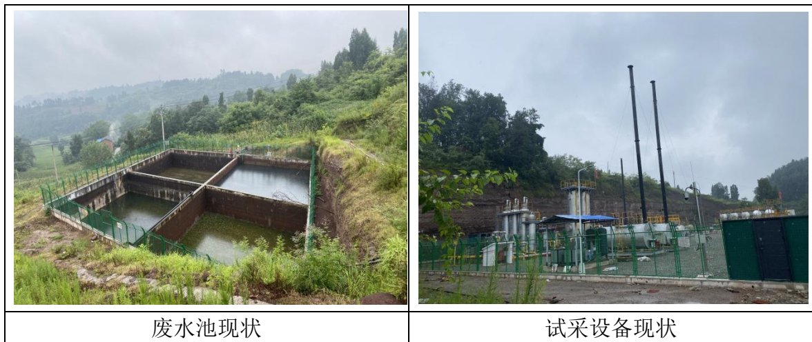
图 4-3 复兴区块泰页 1 试验井组环保措施调查
