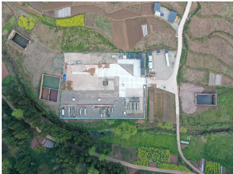
图 4-1 兴页 2HF 井现场情况
