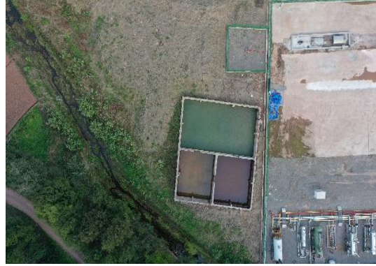
井场废油收集池
