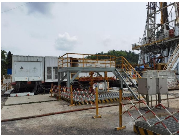
关键部位水泥硬化处理
