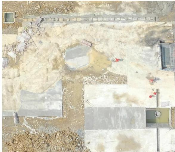
图 6-4 关键位置水泥硬化
