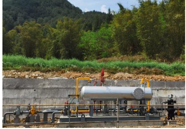
图 6-6 边坡硬化、设置挡墙
