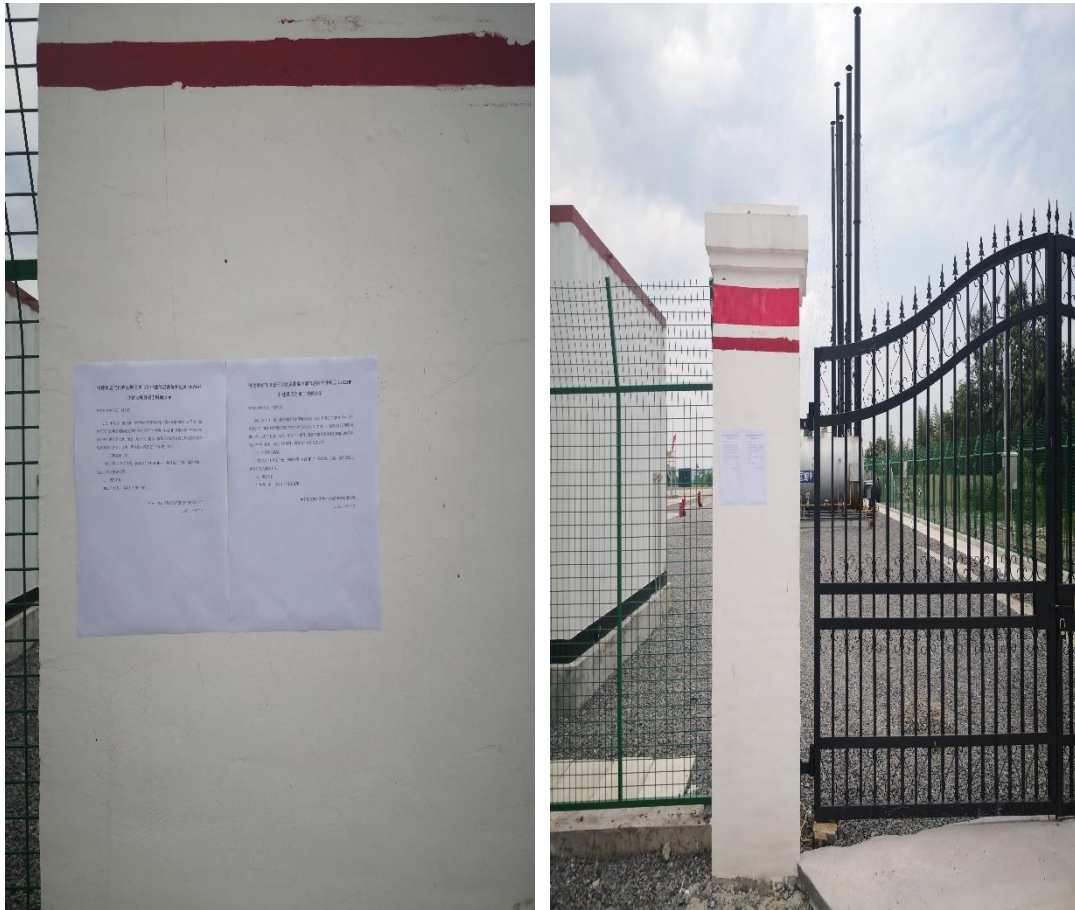
图 1 现场竣工及调试公示照片
