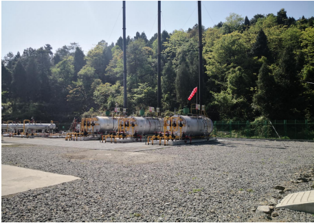
焦页 66 号扩平台水套炉及排气筒
