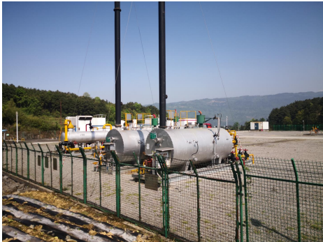
焦页 14 号扩平台水套炉及排气筒
