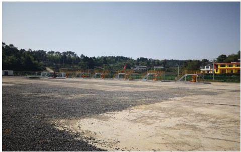
焦石 1 号扩平台井场碎石铺垫及井口区硬化
