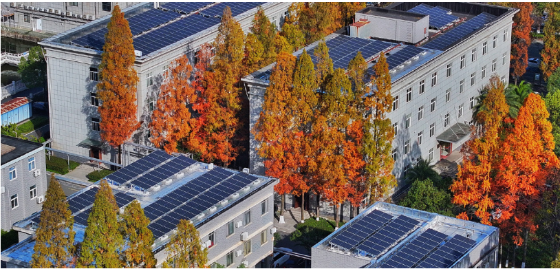
江汉油田屋顶光伏发电
