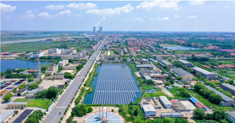
江汉油田清河采油厂漂浮式光伏电站
