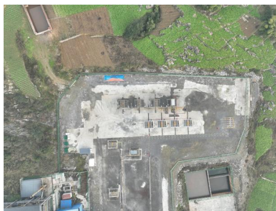
植被恢复（焦页 8 号平台）
