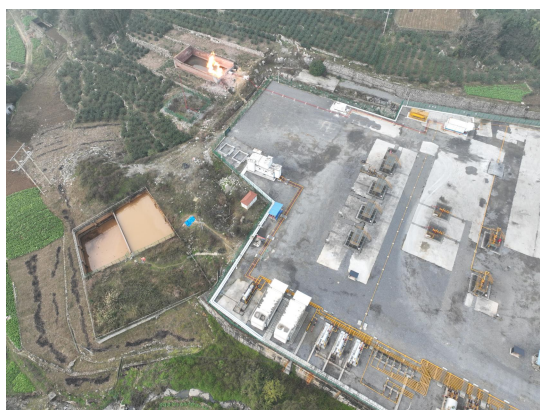
植被恢复（焦页 10 号平台）
