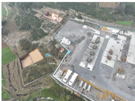
井场硬化（焦页 10 号平台）
