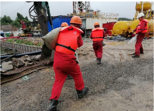
应急演练（施工单位）
