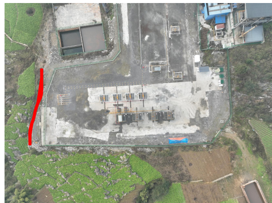
截排水沟（焦页 8 号平台）
