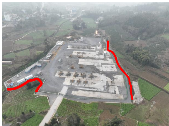
截排水沟（焦页 10 号平台）
