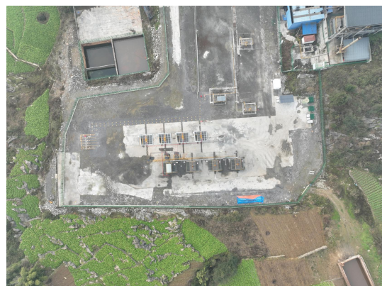
井场硬化（焦页 8 号平台）
