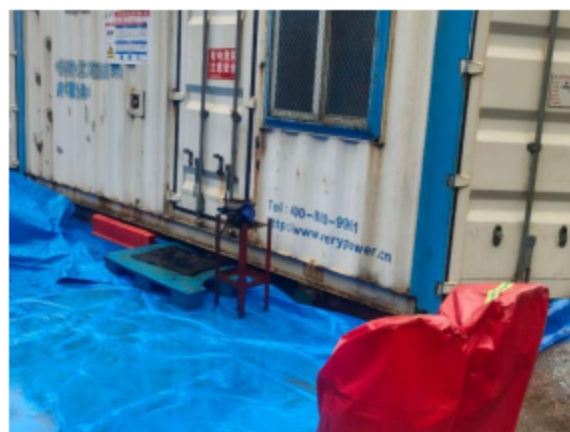
压裂设备区铺设防渗膜
