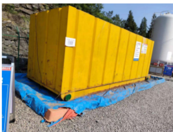
压裂设备区铺设防渗膜
